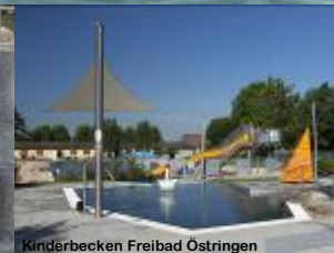
Kinderbecken Freibad Östringen
